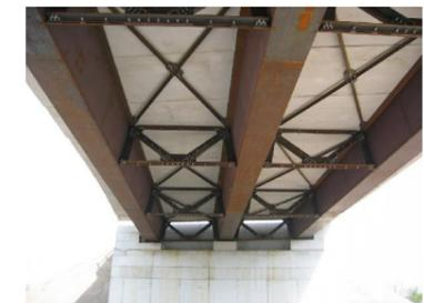
Ognuna delle due travate e' costituita da 3 cassoncini metallici, a sagoma trapezia, muniti dei necessari connettori, del tipo a piolo, necessari per garantire un efficiente collegamento fra la parte metallica e la sovrastante soletta in calcestruzzo, di spessore leggermente variabile, con minimo da 22 cm. La soletta viene gettata su predalle prefabbricate attestate sulle piattabande superiori delle tre travi a cassoncino.
